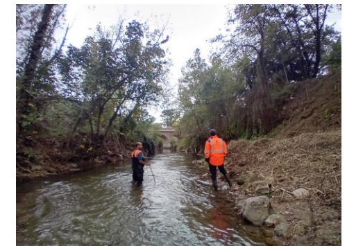
Réception de chantier avec EDEA, Huveaune - Novembre 2025
