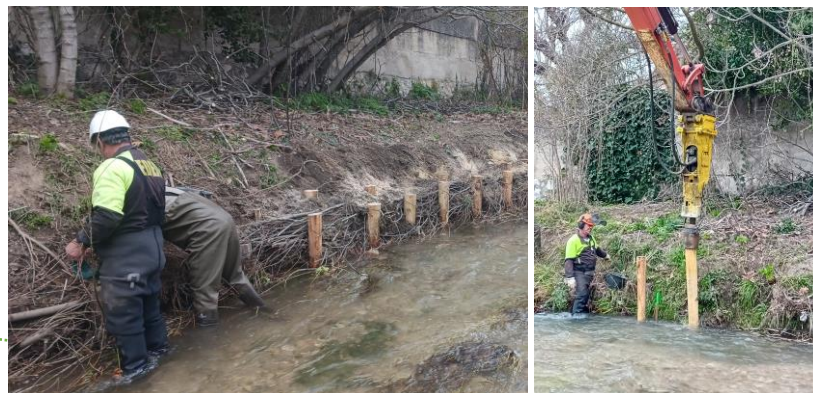
Réfection et extension de fascine, Huveaune, La Penne sur Huveaune - Février 2025
