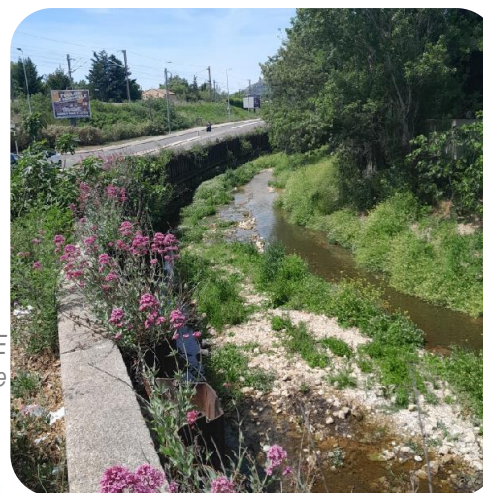
Suivi des assècs réalisés par l'EPAGE HuCA au pont de Lamagnon à Aubagne
