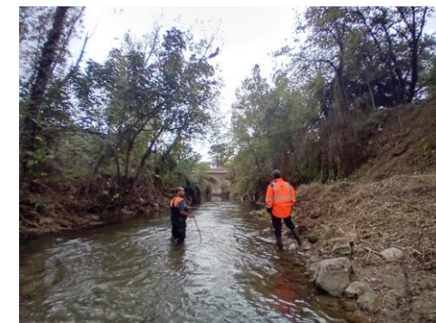
Réception de chantier avec EDEA, Huveaune - Novembre 2025
