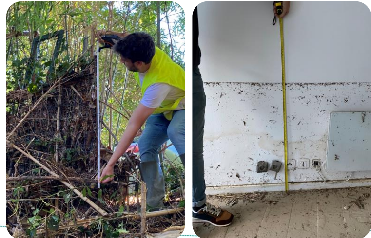
Relevé de laisse de crue sur le Jarret (gauche) et chez un riverain à Pont de Vivaux (Marseille)
