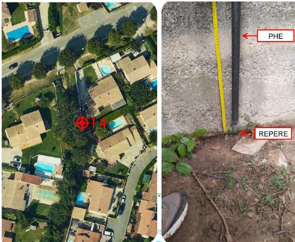
Relevé de laisse de crue chez un riverain du Fenouilloux (Saint-Zacharie en juin 2023) – sur le mur d'habitation (40 cm d'eau dans le garage)
