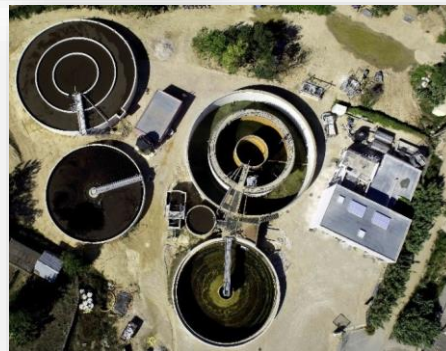
STEP Auriol- St-Zacharie pendant les travaux (SPL eau des collines)
