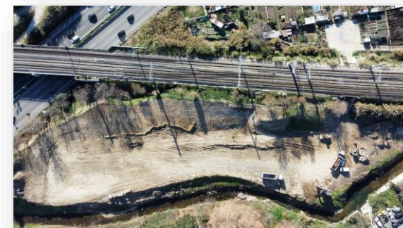
Zone amont après travaux de terrassement
