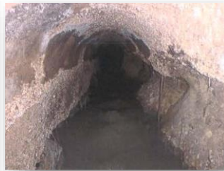
Effondrement Ovoïde (SPL eau des collines)
