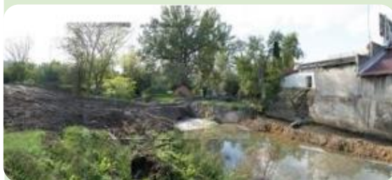
Le secteur du seuil avant travaux (gauche) et illustration après travaux (droite)
