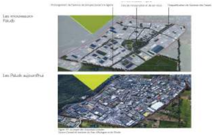
Figure 17. Le projet des années 1950 et l'état de rétrogradation de la voirie. Source: Conseil municipal de Fexes, d'après les données de l'Etat.
