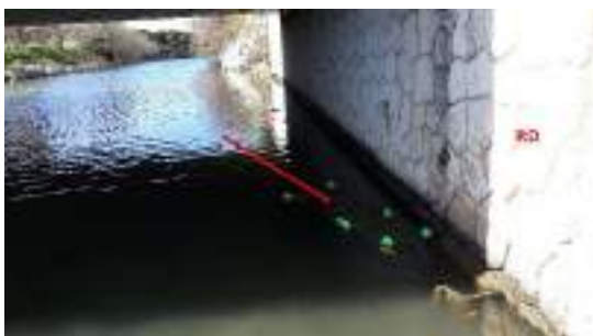
Flottang sous passerelle Borely à Marseille
