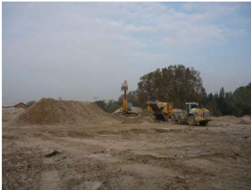
Figure 13: Chantier de dépollution du site "3moteurs Baudoin" avant la construction d'un Castorama à Marseille - Saint-Loup ©DEKRA CONSEIL HSE
