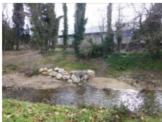
Figure 15: Bassin de rétention Castorama à Marseille- St Loup ©SIH
