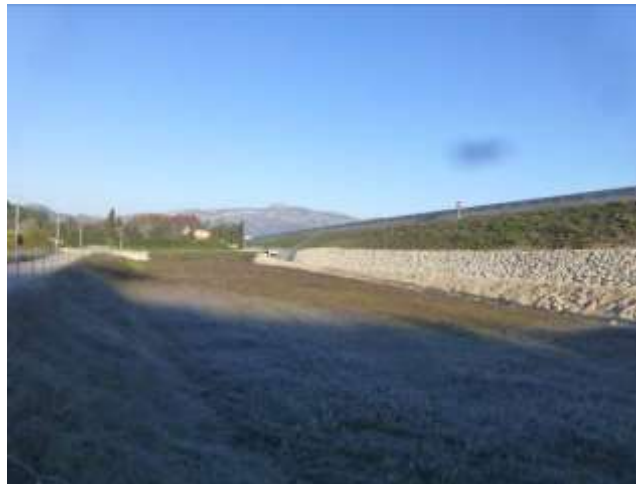
Figure 16: Bassin de rétention ESCOTA à Aubagne
