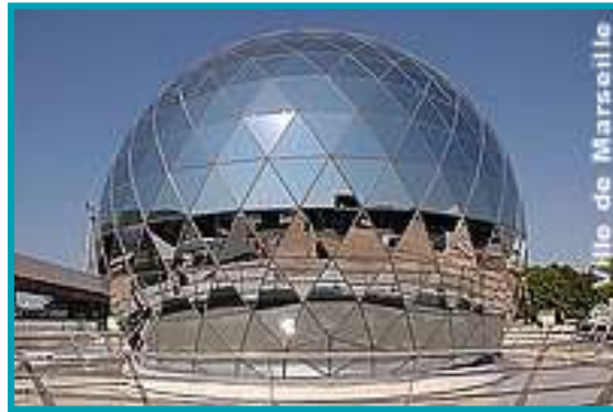
Figure 6: STEP Marseille - Géolide (source Ville de Marseille)
