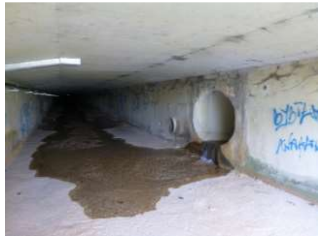
point d'alimentation du Jarret à Plan-de-Cuques (surverse bassin de la Montade) ©SIH
