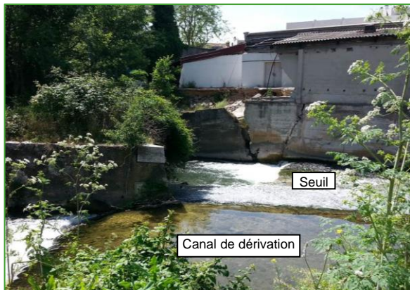
Bâtiment du dépôt vente la Trouville en partie effondré : le seuil renvoie les eaux de l'Huveaune directement vers les bâtiments fragilisés, entraînant une dégradation, notamment lors de fortes crues
