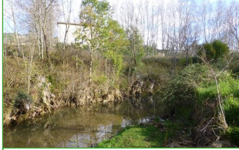
Secteur 2 : risque d'effondrement des berges au droit des habitations riveraines
