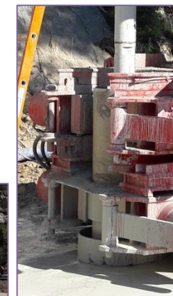
Travaux de réalisation du nouveau forage
