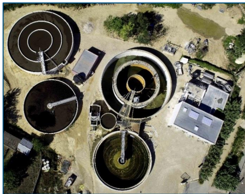
STEP d'Auriol St Zacharie pendant les travaux
