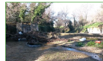
Vue seuil de St Menet de l'amont vers l'aval
