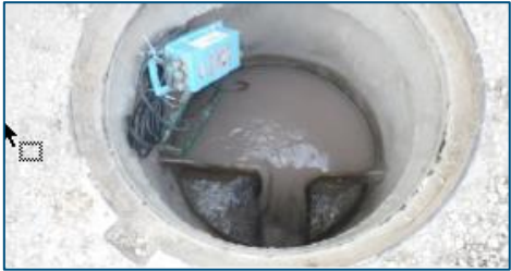
Déversement dans un pluvial et mesure de débit
