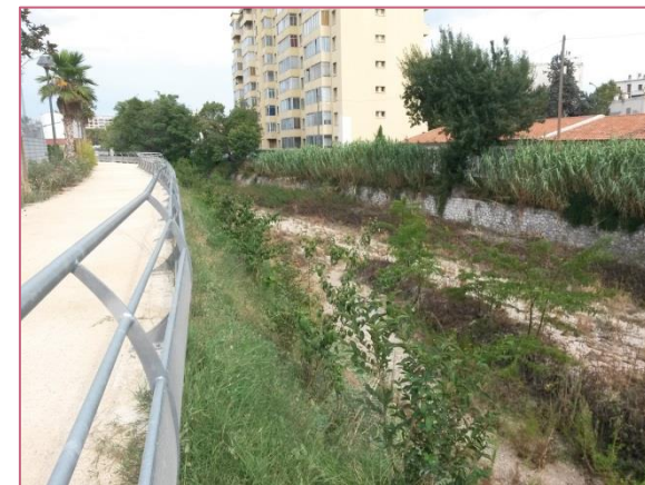
Reprises de berges réalisées par le SIBVH en partenariat avec la ville de Marseille dans le cadre des travaux d'aménagement du stade Vélodrome
