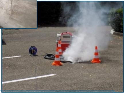
Déversement dans le Merlançon et Fumigation
