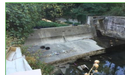
Structure transversale large et imposante Présentant quelques failles et usures
