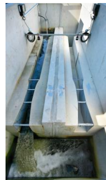
Comptage des eaux traitées de la nouvelle STEP d'Auriol St Zacharie
