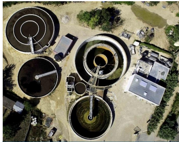
STEP d'Auriol St Zacharie pendant les travaux
