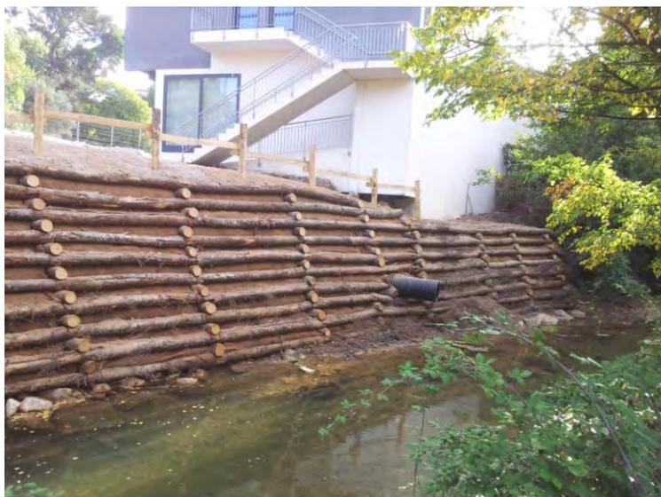
**Figure 72: Exemple d'aménagement innovant des berges de l'Huveaune à Roquevaire suite à un problème important d'érosion sur la parcelle d'une zone d'activité ©SIH**
