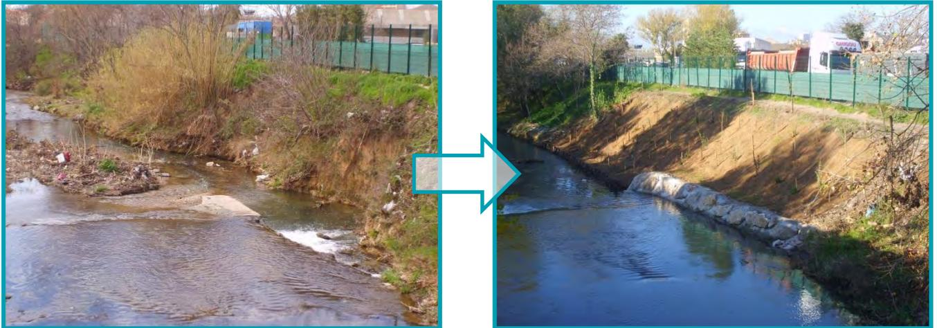
Figure 74 Travaux de reprise des berges- Marseille ©SIH
