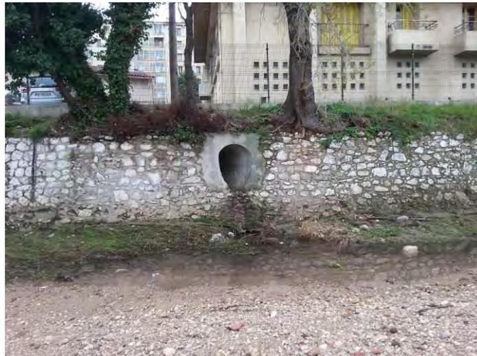
Figure 48: Exutoire d'un réseau pluvial - Marseille Ste Marguerite ©SIH
