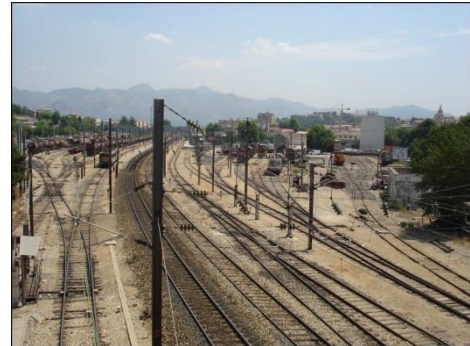
Figure 3 : Voie ferrée TER au Nord d’Aubagne
