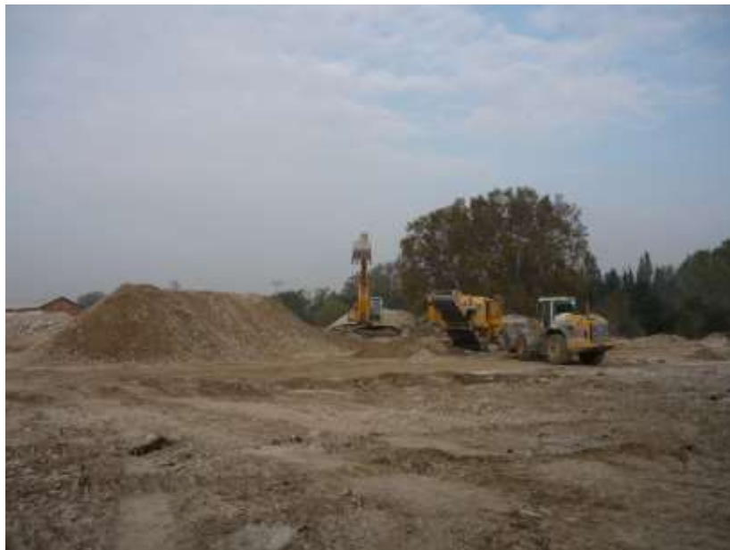
Figure 13: Chantier de dépollution du site "3moteurs Baudoin" avant la construction d'un Castorama à Marseille - Saint-Loup ©DEKRA CONSEIL HSE
