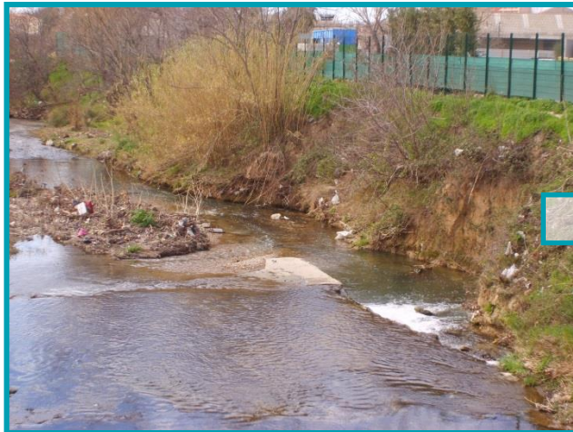
Marseille- travaux de reprise de berges ©SIH
