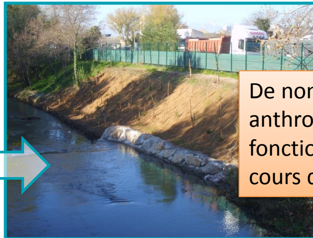
Marseille- travaux de reprise de berges ©SIH
