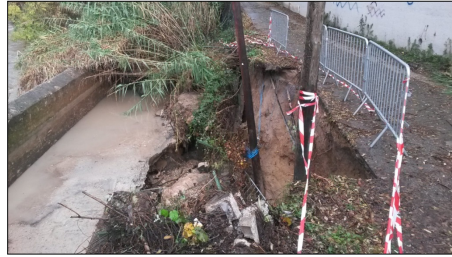
Effondrement de la berge / mur du bâtiment depuis 2003 Effondrement du béal et de la route menant aux jardins Coder
