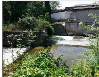
Effondrement de la berge / mur du bâtiment depuis 2003 Effondrement du béal et de la route menant aux jardins Coder
