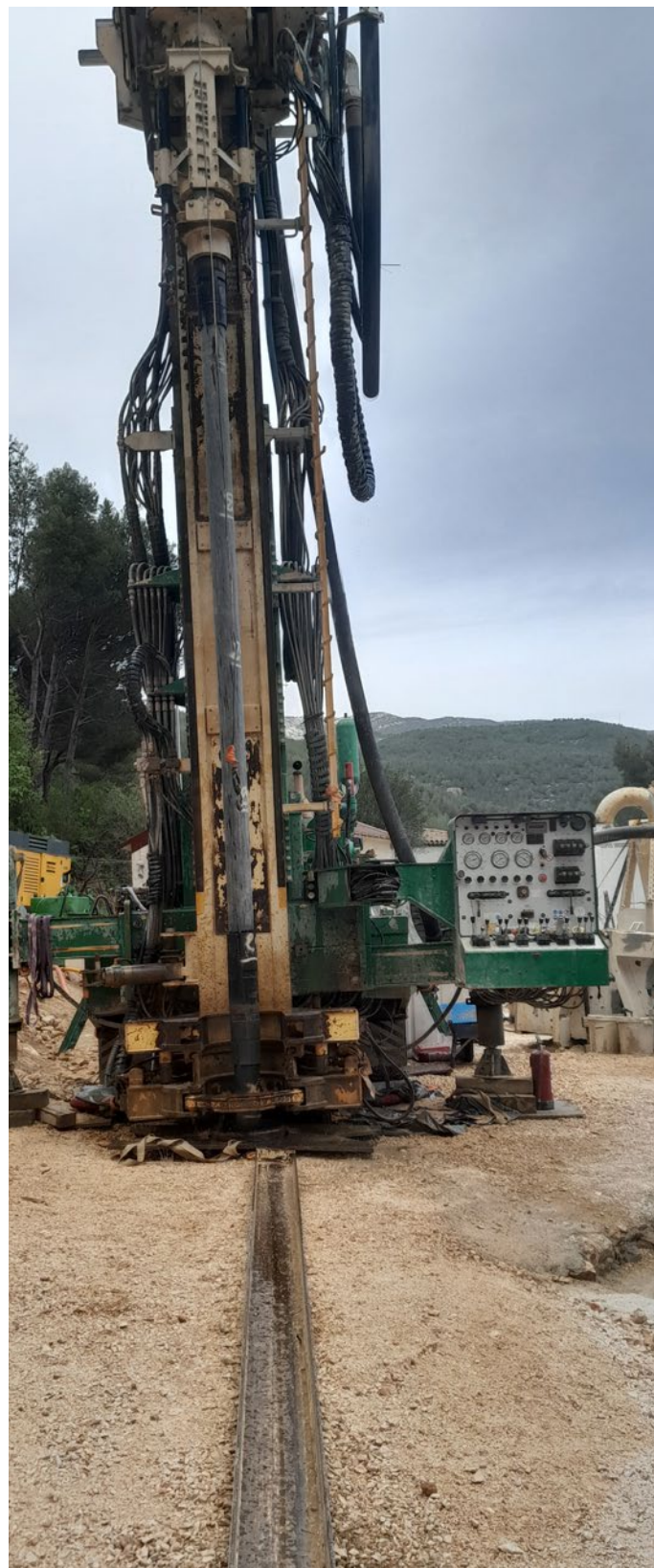
Foreuse pour la réalisation d'un forage d'eau sur la commune de Cuges-les-Pins
