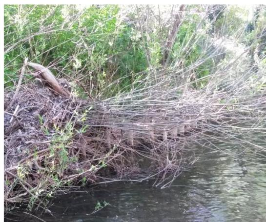
Figure 12 : Fascine de saules dont le développement est susceptible, à terme, de constituer un obstacle à l'écoulement
