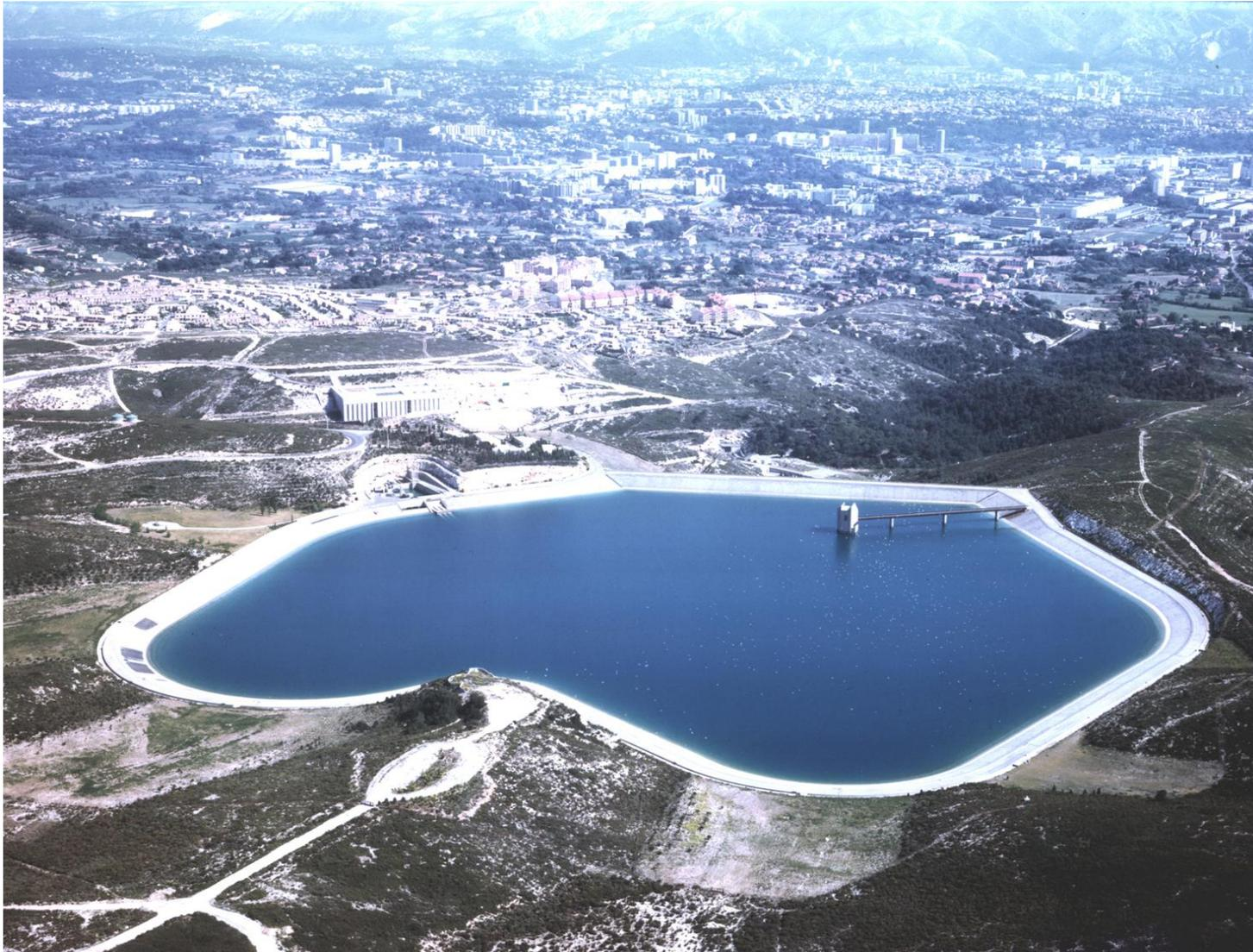
**Construit en 1973** sur le flanc sud de la Chaîne de l'Etoile, ce réservoir de **3 millions de M<sup>3</sup>** d'eau s'inscrit ainsi comme le dernier maillon d'une chaîne d'ouvrage qui dota la ville de Marseille d'une **seconde adduction d'eau**.
