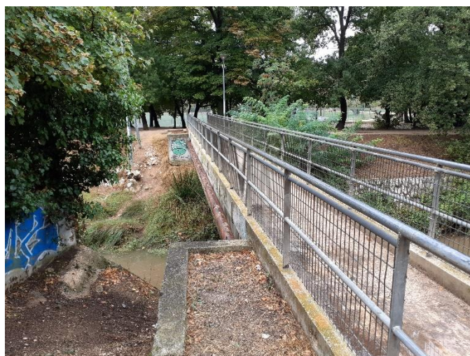
Vue de la passerelle amont qui sera déposée, ces fondations seront également démolies et un nouvel ouvrage sera reconstruit plus en aval
