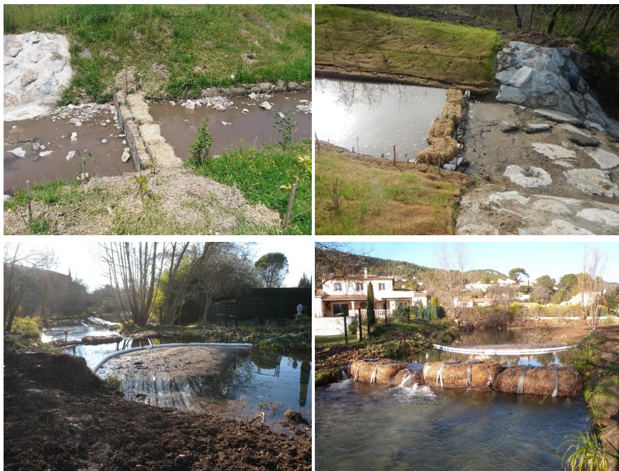
Exemples de filtres à MES en travaux rivière
