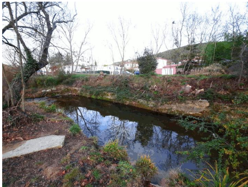
Chantier de fascines sur l'Huveaune, aux Pibles (Auriol)
