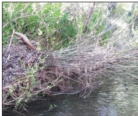
Figure 12 : Fascine de Saules dont le développement est susceptible de constituer un obstacle à l'écoulement
