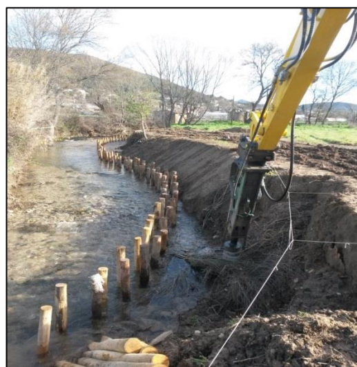
Figure 2 : Réalisation de travaux d'aménagement de berges de l'Huveaune à Auriol par le SMBVH
