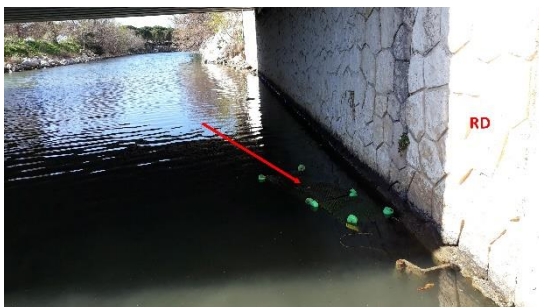
Flottang sous passerelle Borely à Marseille
