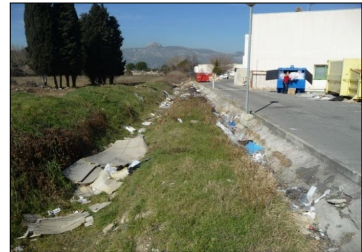
Réseau pluvial dans la zone des Paluds
