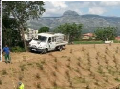
Travaux de réhabilitation de berge à Auriol (haut)
