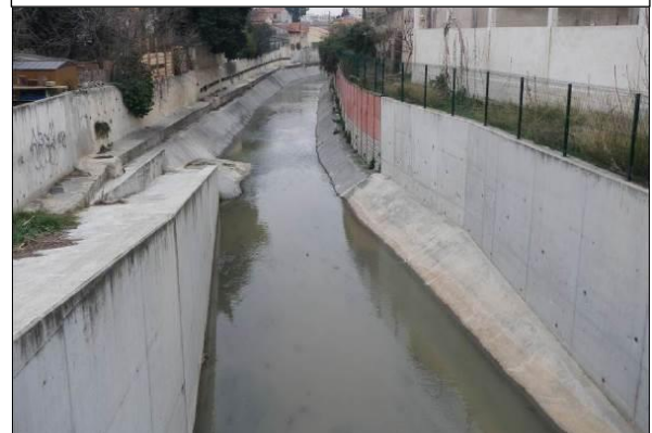
Cuvelage au niveau du Jarret Source : SAFEGE
