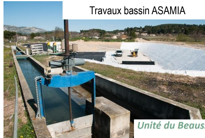
Pose de la géomembrane au fond du bassin
