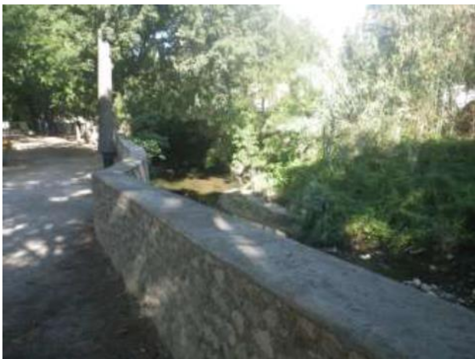
Exemple d'ouvrage longitudinal répertorié à Marseille– source : SMBVH - Artelia
