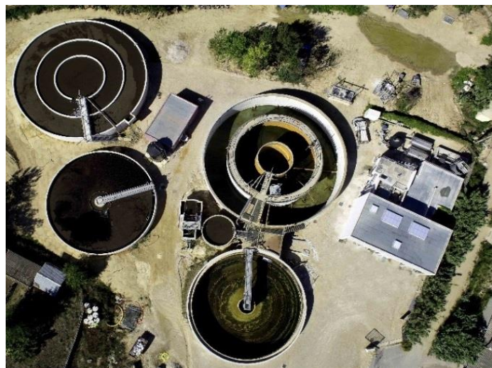
STEP d'Auriol St Zacharie pendant les travaux
